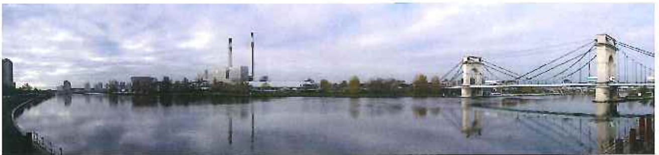
Vue du secteur des Ardoines depuis Alfortville (source SFURA, 2011)
